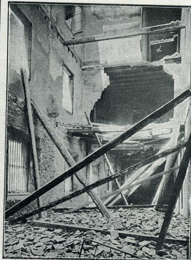
Interior del convento de Paules sito en la calle de Provenza, entre Muntaner y Aribau
